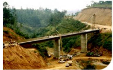
Pont de Gitarama (Rwanda)
