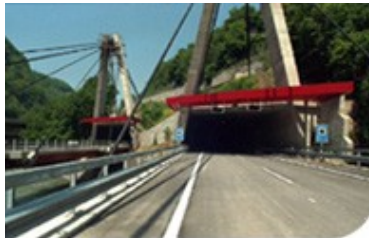
Tunnels de l'Arzillier, A9, Lavey (Suisse)
