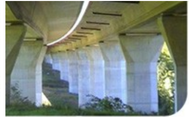
Ponts de la Golaz, A1, Yvonand (Suisse)
