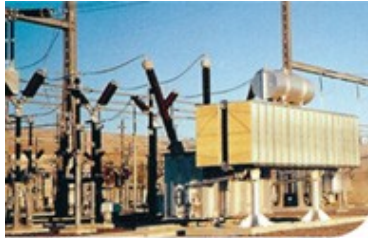
Aménagement hydroélectrique d'Atatürk (Turquie)
