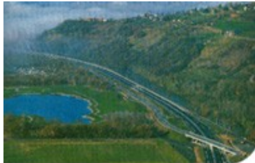
Autoroute A43, Vallée de la Maurienne (France)
