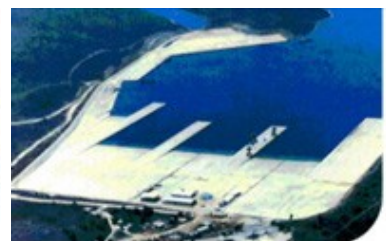
Spécification, supervision et contrôle des EIE pour 29 ports (Grèce)
