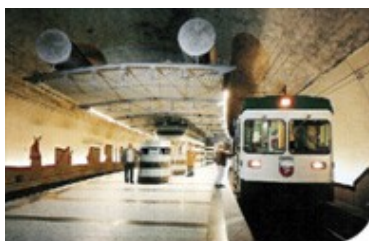
Tronçon souterrain du LEB, Lausanne (Suisse)
