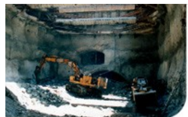
Construction du métro d'Alger (Algérie)
