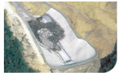
Aménagement d'une décharge contrôlée (CH)
