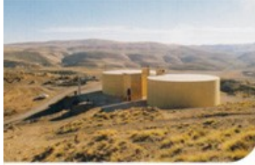
Réservoirs en béton, Aïn el Kebira (Algérie)
