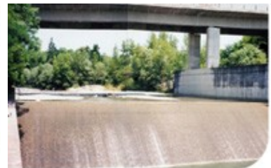
Correction du Fier, Annecy (France)
