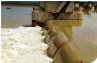
Barrage de régulation, Oued Loukkos (Maroc)
