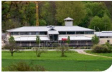
Centre d'Intervention de Mertert (Luxembourg)
